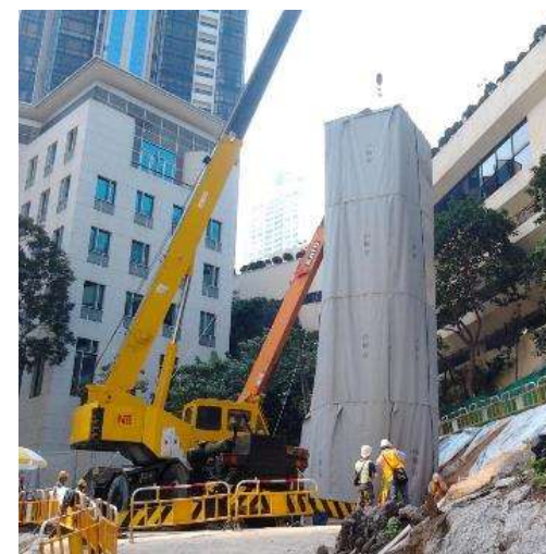
以隔音物料包裹機械
