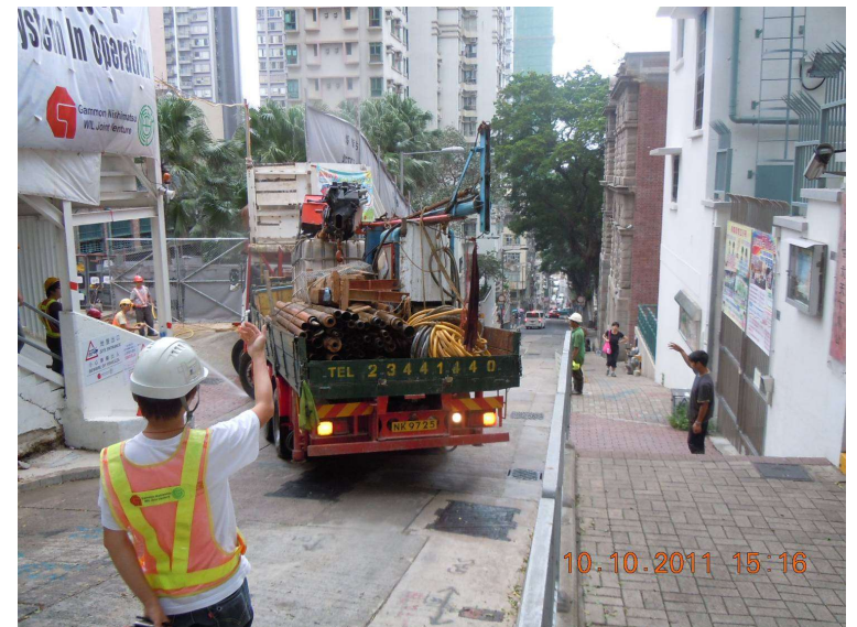
工地出入口派員協助工程車輛進出，以及提醒行人和駕駛人士路面情況
