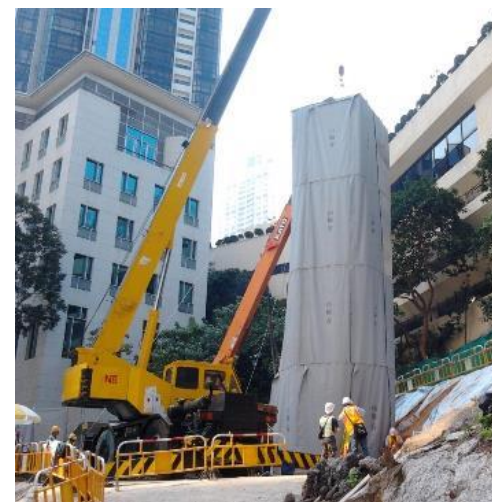
以隔音物料包裹機械
