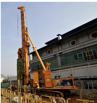
地基(非撞擊式樁柱及樁帽)*
