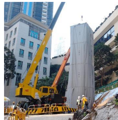
以隔音物料包裹機械
