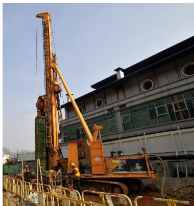
地基 (非撞擊式樁柱及樁帽)*
