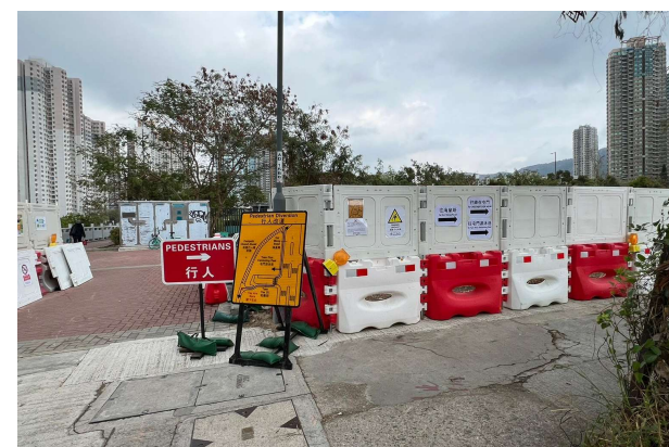
屯門河（東岸） 屯門游泳池用地及毗鄰行人路
