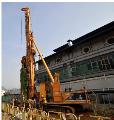
地基 (樁柱及樁帽)*
