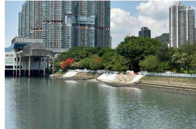
以混凝土磚、石料及鋼鐵物料 興建臨時工作台
