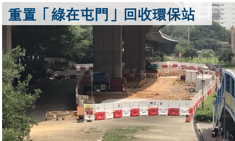
龍澤路近龍富路橋底工地
