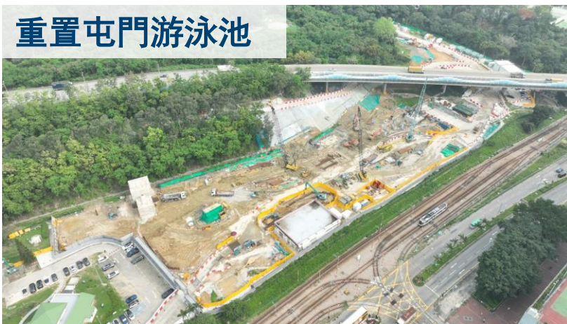
屯門康樂及體育中心內的工地
