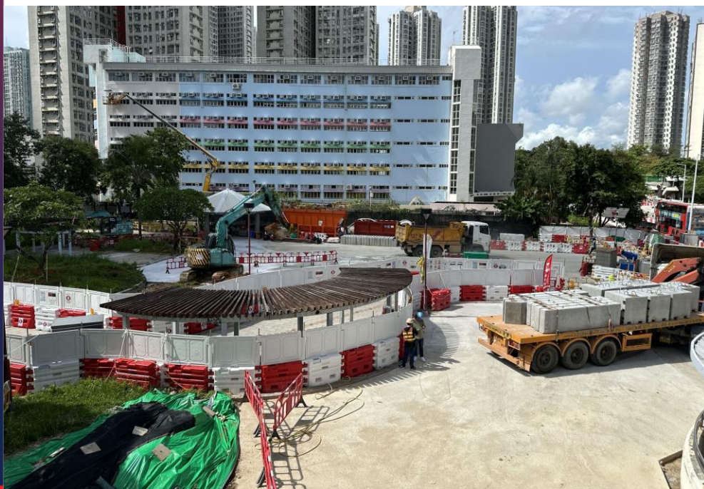
工地平整及建造臨時行人通道
