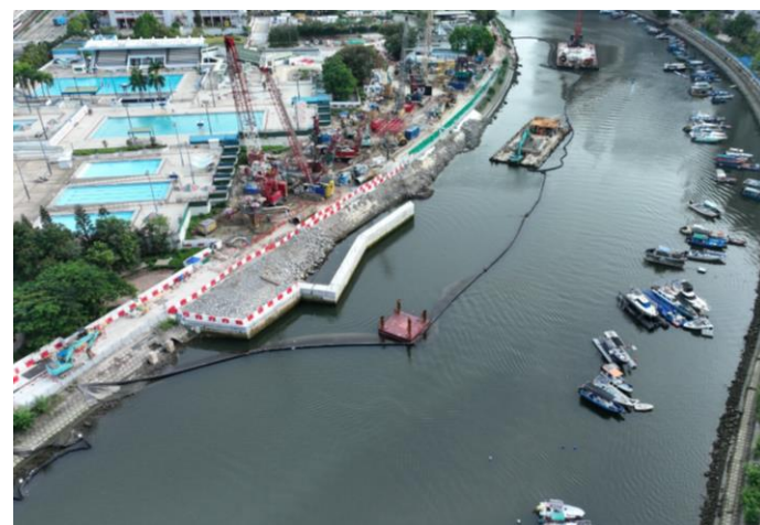
以混凝土磚、石料及鋼鐵物料 興建臨時工作台
