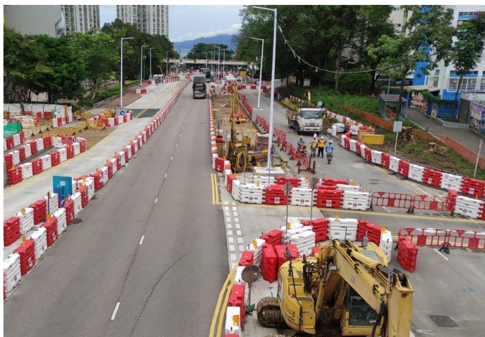
地下管綫改道工程及 拆卸湖月橋前的準備工作
