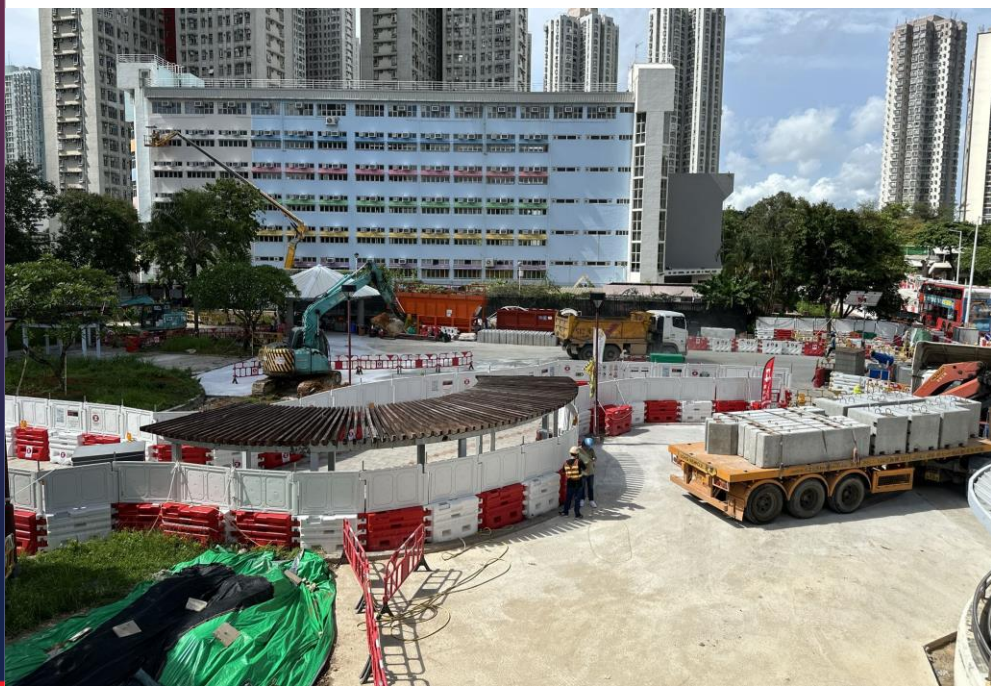
工地平整及建造臨時行人通道
