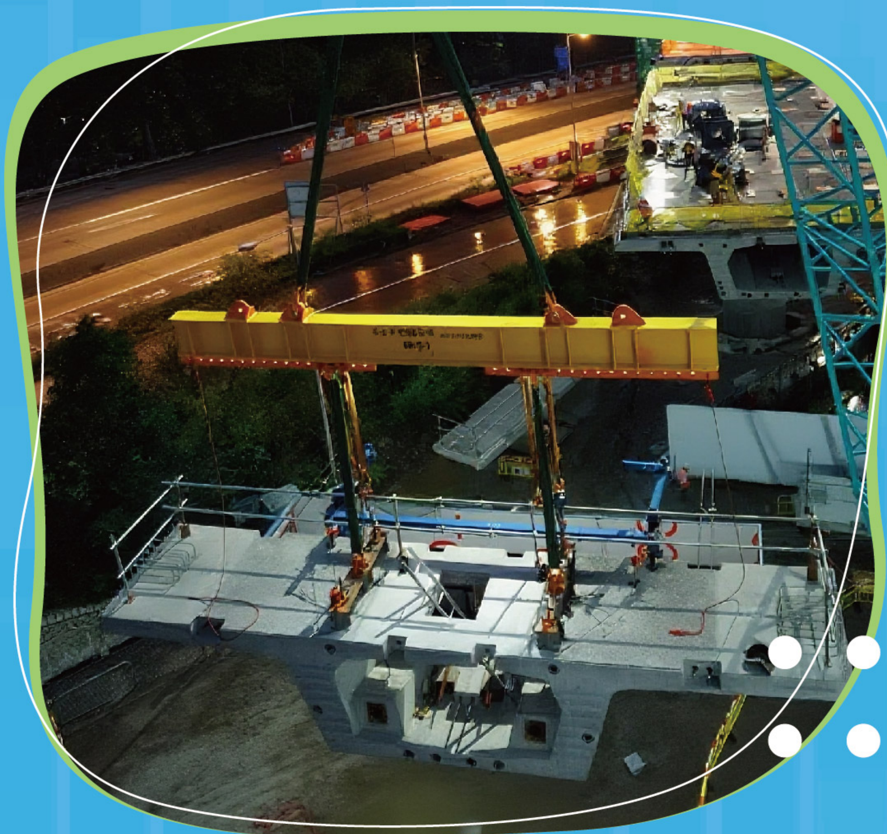
▼ 高架橋預製組件參考圖片 Reference photo of precast viaduct segment
