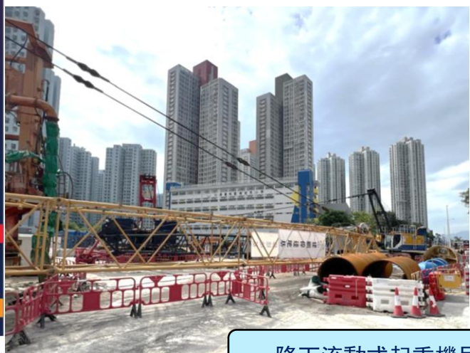
降下流動式起重機吊臂及設於安全狀態
